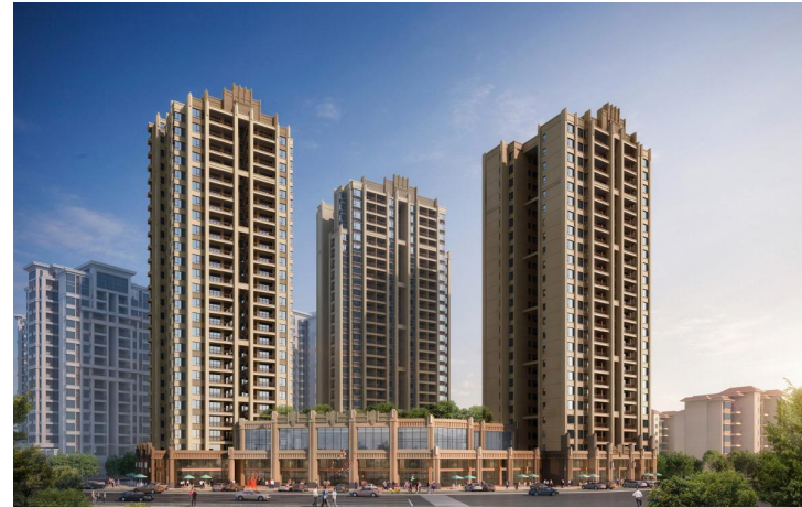
图为海建股份公司承建的海口市秀英区永万东片区一期（化工二厂）城市更新项目
