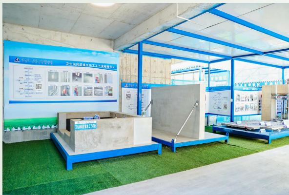
卫生间同层排水工艺样板
