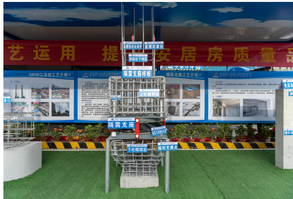
隔震支座样板
