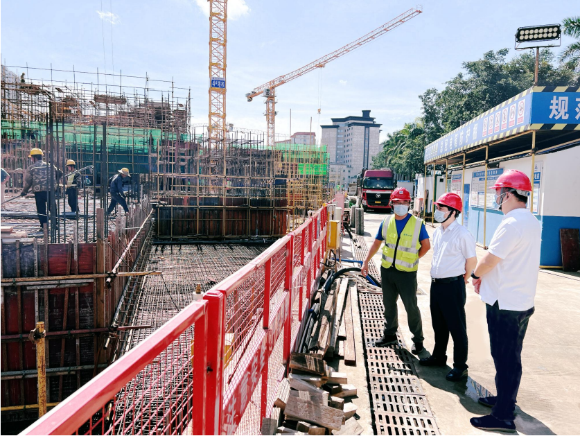
易伟在省机关海府大院规划改造项目现场检查
