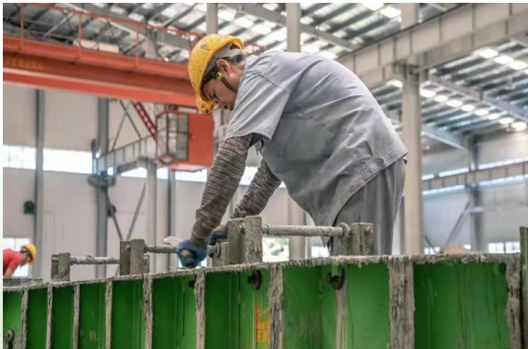
海建产业化工人正在制作预制楼梯 摄影/杨思懿
