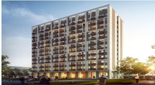
产业化公司宿舍楼
