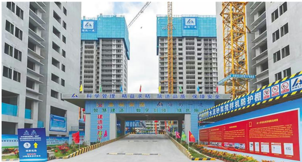
正在建设的金城·金甸水岸项目。
